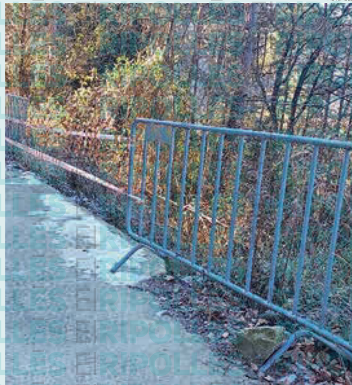
Ja s'està treballant en les obres de reparació d'aquesta esllavissada
