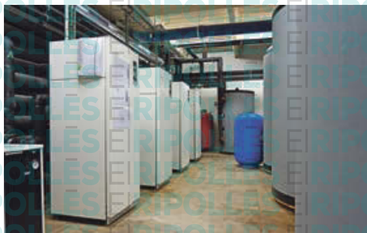
Instal·lació de geotèrmia a Vall de Núria
