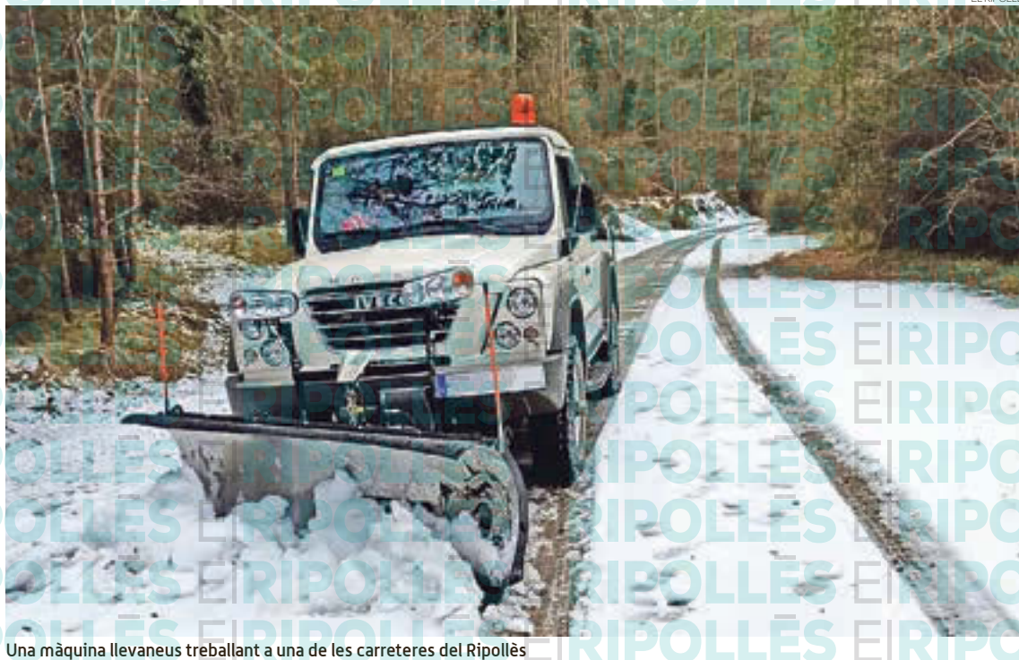
Una màquina llevaneus treballant a una de les carreteres del Ripollès
