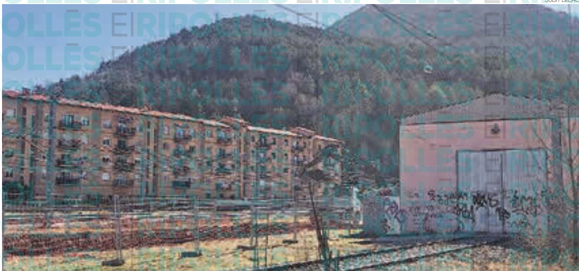
Obres de construcció de la nau provisional a Ripoll
