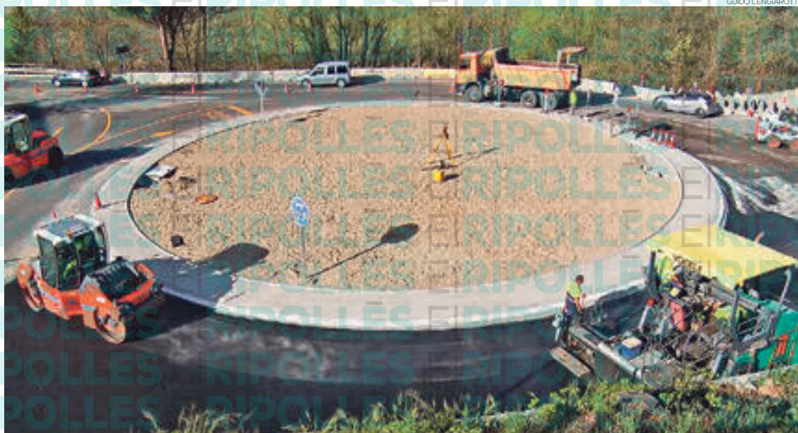
Les obres a la rotonda, aquest dimecres
