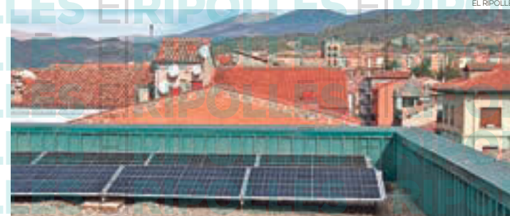
Instal·lació de plaques solars en cobertes d'equipaments municipals
