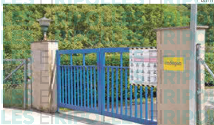
La depuradora de Sant Pau de Segúries
