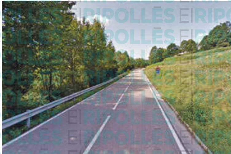
Carretera de Vallfogona
