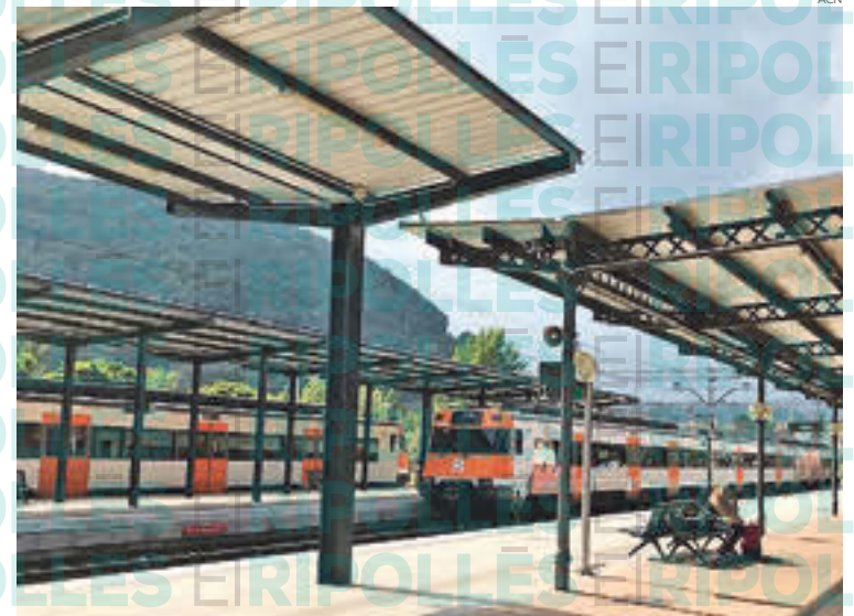
A Ripoll s'hi està construint la futura base de manteniment de trens
