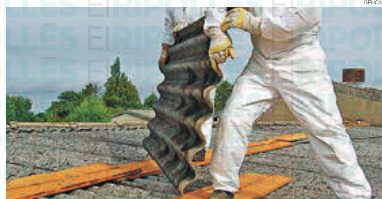
Operaris retirant amiant de teulades
