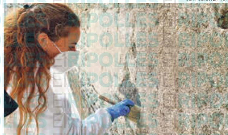
Els treballs han permès conservar les dues façanes que presentaven un estat molt dolent
