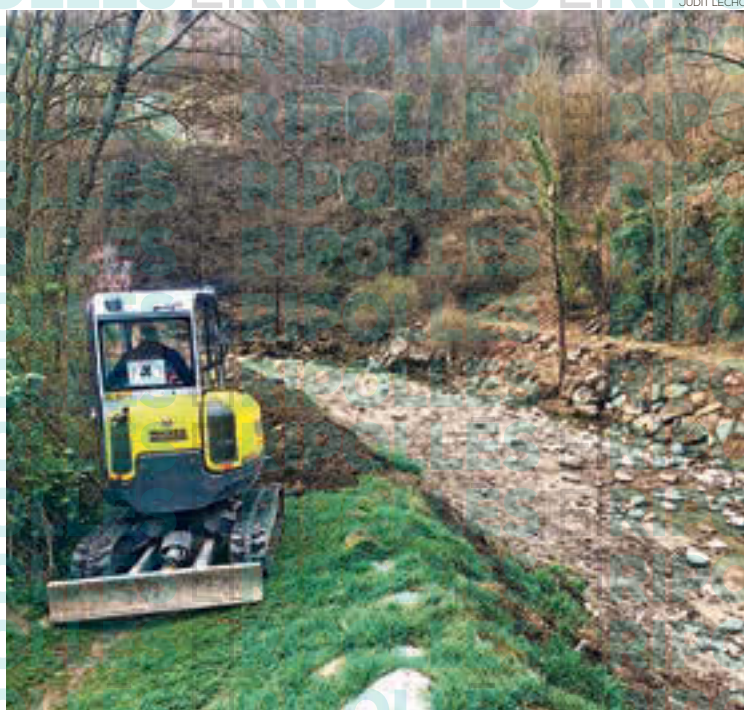
Obres al barri de la Creu de Campdevàno!
