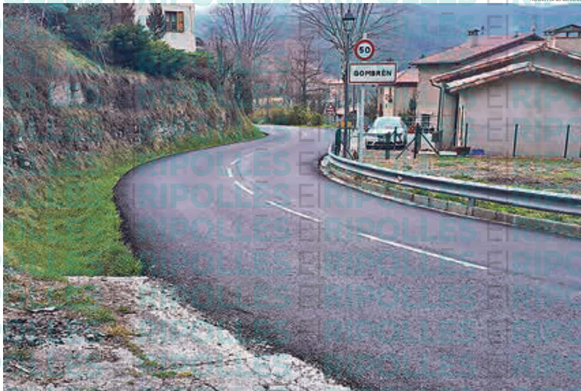
Pas conflictiu a Gombren, on es construirà la vorera perquè puguin passar els vianants
