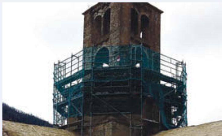
Una de les imatges més espectaculars és la bastida al voltant de la torre
