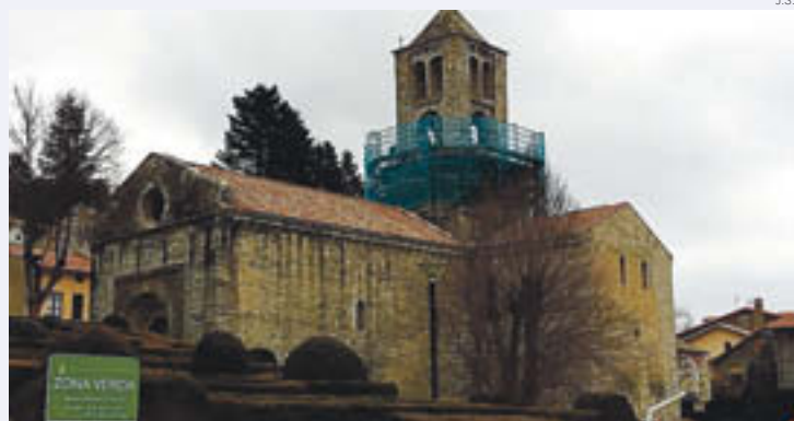
Les obres són ben visibles des de diversos punts de la població
