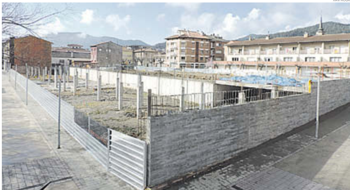
Aquest és l'estat actual de les obres de construcció de la nova escola Pirineu de Campdevàrol
