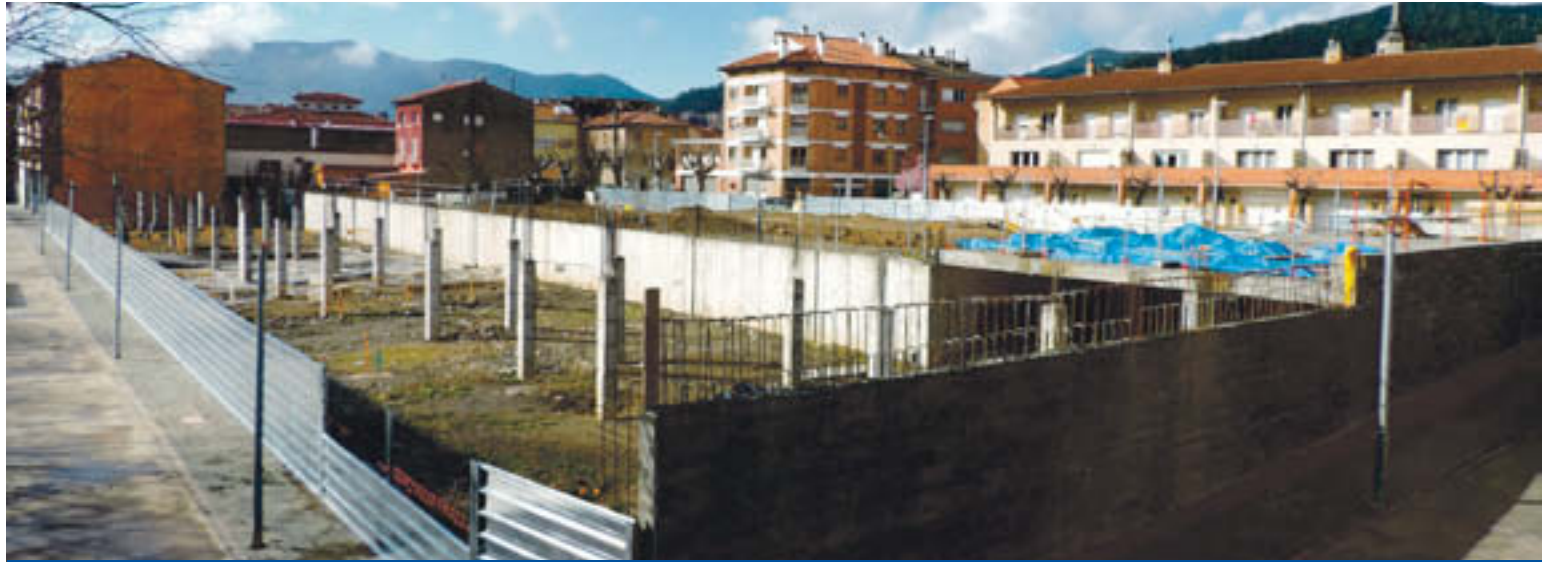
Estat actual de les obres, les quals estan paralitzades des del passat mes de novembre pel departament d'Ensenyament
