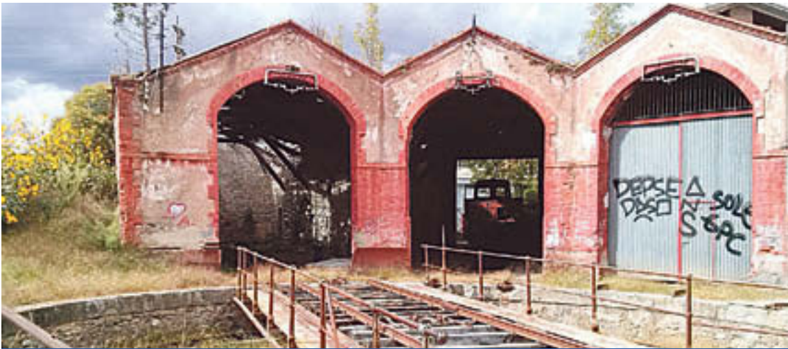
Tots els equipaments reclamats es troben en estat ruïnós
