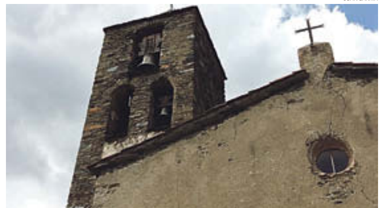
El campanar, una de les actuacions que ja s'han dut a terme
