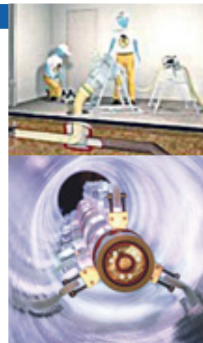
Rehabilitació de canonades
