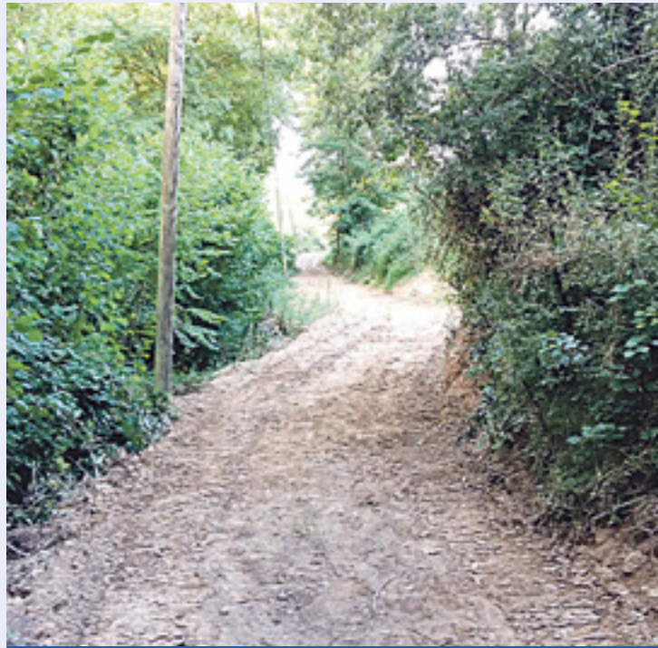
Una de les actuacions que s'estan fent al Camí Ral de Sant Pau de Segúries
