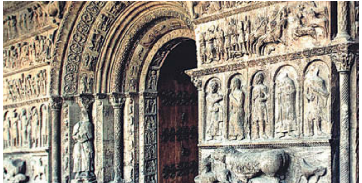
Dies abans de l'inici de la intervenció es començaran a instal·lar les vestides davant el monument
