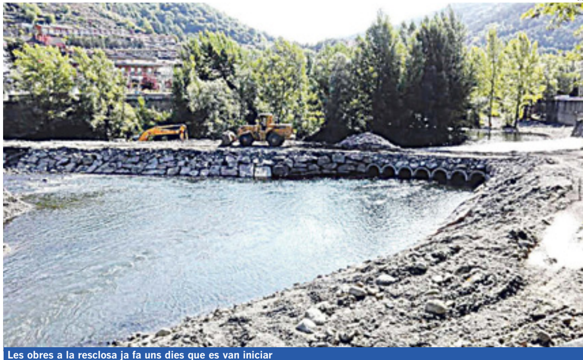
Les obres a la resclosa ja fa uns dies que es van iniciar
