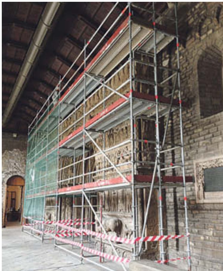
La Portalada amb les bastides que s'han posat per les actuacions
