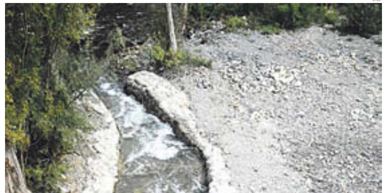
El connector ictícol permet la remuntada dels peixos fins al Ter o el Freser
