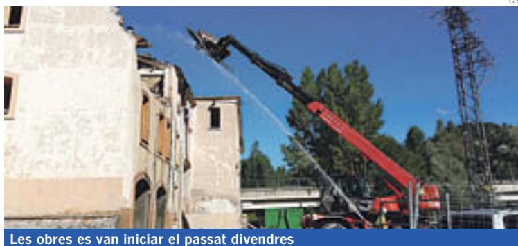
Les obres es van iniciar el passat divendres
