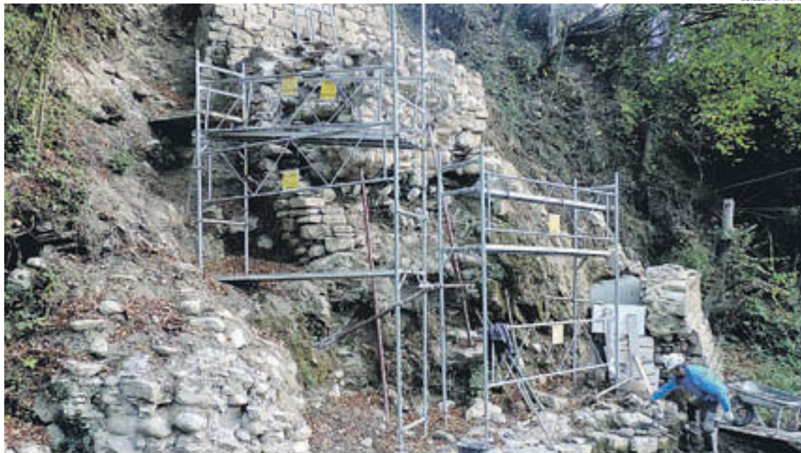
Els treballs són per consolidar les obres ja realitzades en aquest pont d'orgien medieval
