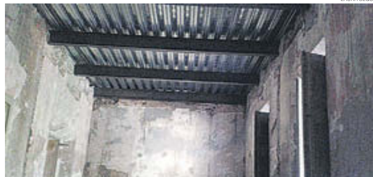
La consolidació de l'edifici, el pas previ a continuar amb la reforma integral
