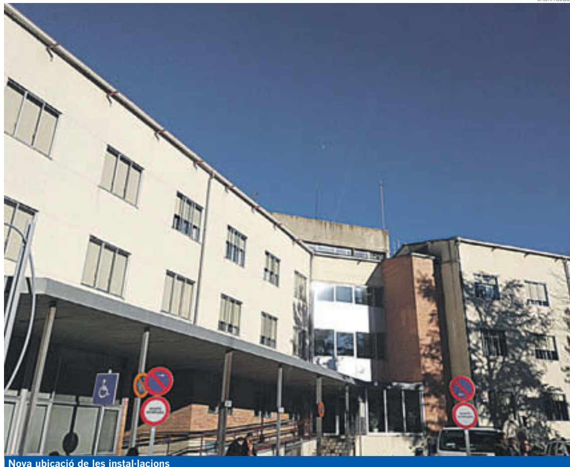
Nova ubicació de les instal·lacions
