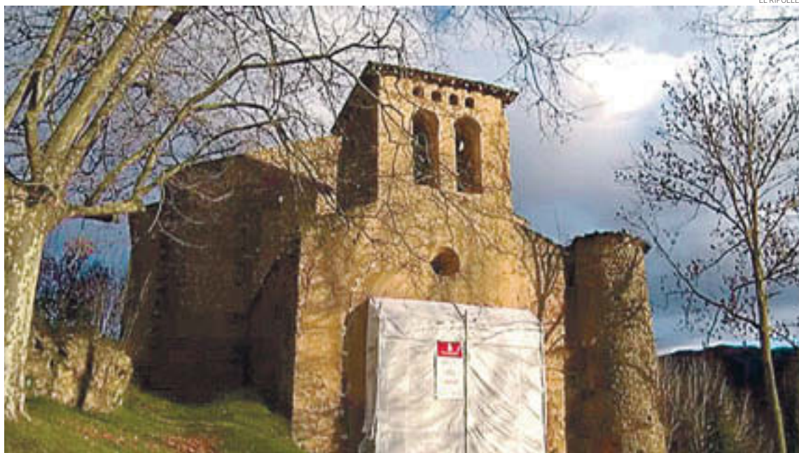
Aquests dies s'està portant a terme les obres de rehabilitació de l'església de Sant Julià
