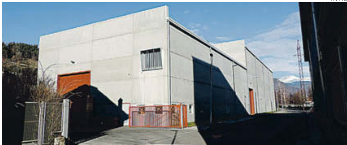
Un informe certifica que el nivell d'emissió de vibracions està per sobre del marc legal establert
