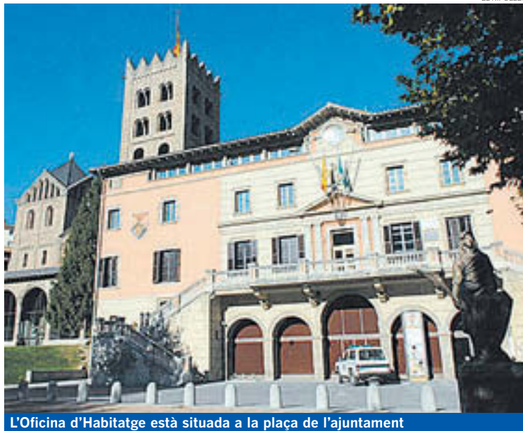
L'Oficina d'Habitatge està situada a la plaça de l'ajuntament
