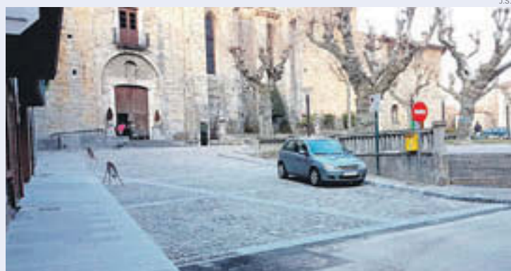
Aspecte com ha quedat la pujada de l'església Santa Maria de Canprodon
