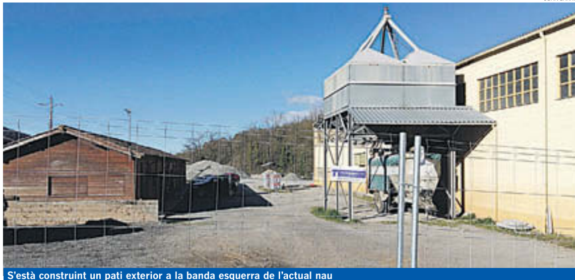
S'està construint un pati exterior a la banda esquerra de l'actual nau
