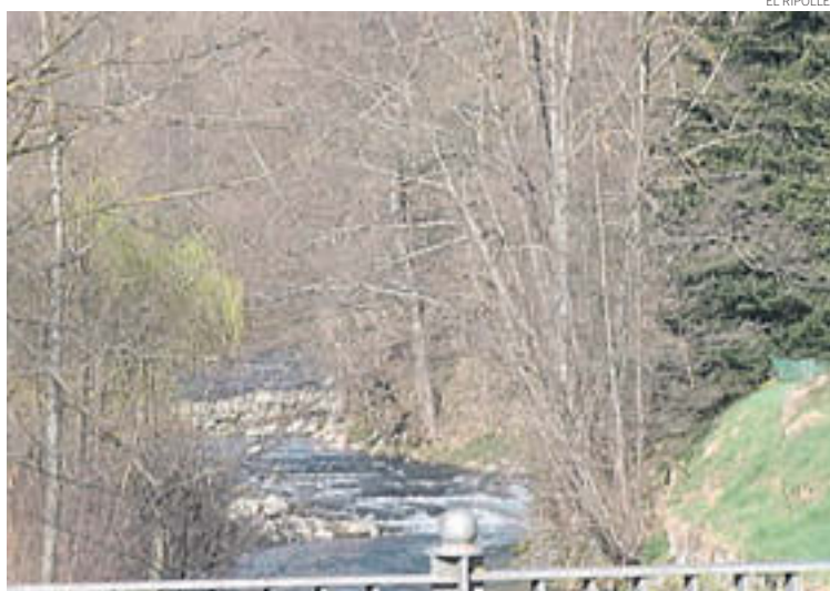
Es reprendran les obres per a la construcció del col·lector de Llanars
