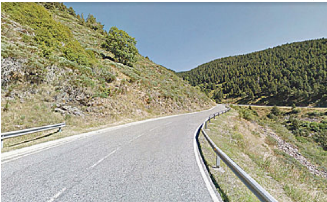
De la Serna va assegurar que s'hi estan realitzant actuacions de seguretat
