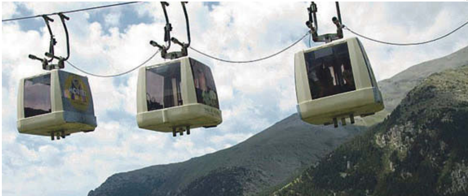
Es renovarà el Telecabina que dona accés a l'Alberg de Joventut de Vall de Núria
