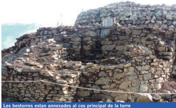
Les bestorres estan annexades al cos principal de la torre
