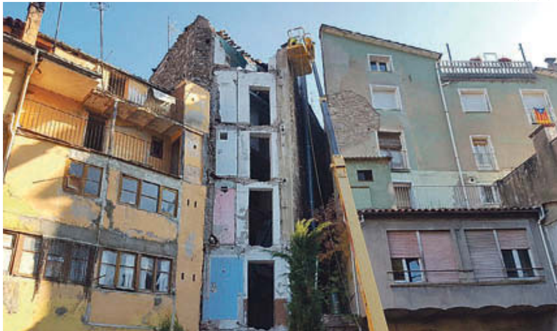
Primeres actuacions a l'edifici per enderrocar
