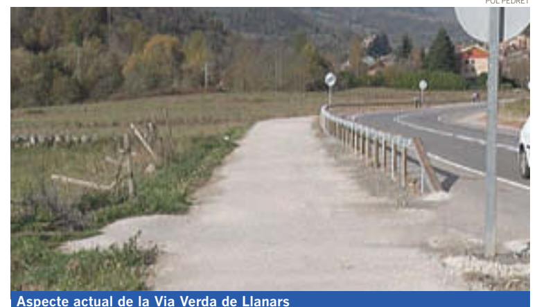
Aspecte actual de la Via Verda de Llanars
