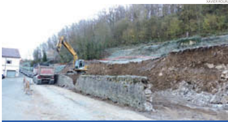
Aspecte que ofereix aquests dies l'aparcament de Can Crehuet, a Sant Joan
