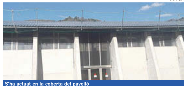
S'ha actuat en la coberta del pavelló
