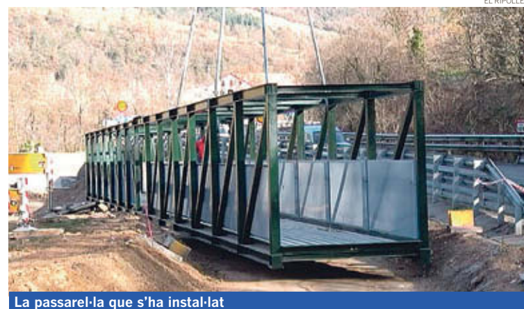
La passarel·la que s'ha instal·lat
