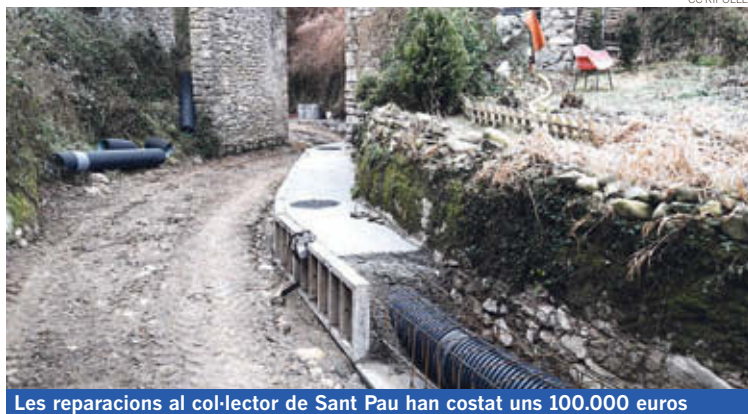
Les reparacions al col·lector de Sant Pau han costat uns 100.000 euros
