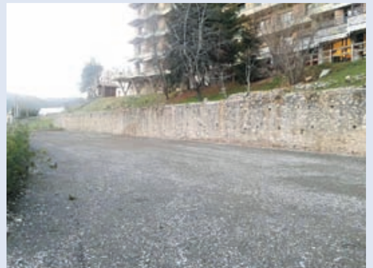
Els nous aparcaments sota mateix de l'edifici de la Fundació Guifré
