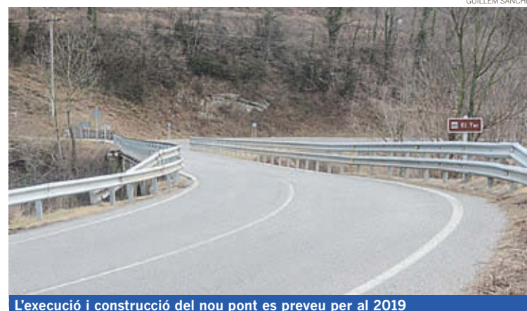
L'execució i construcció del nou pont es preveu per al 2019
