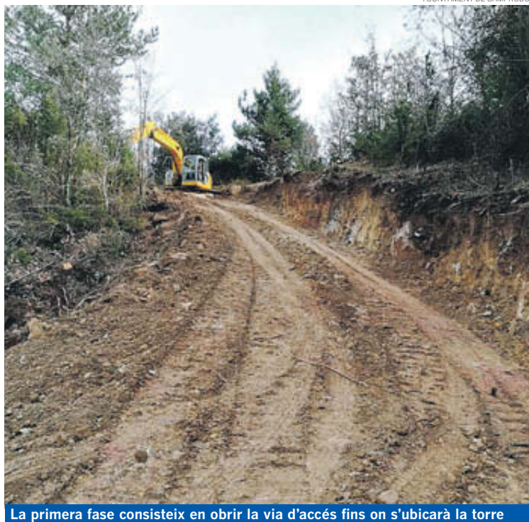
La primera fase consisteix en obrir la via d'accés fins on s'ubicarà la torre
