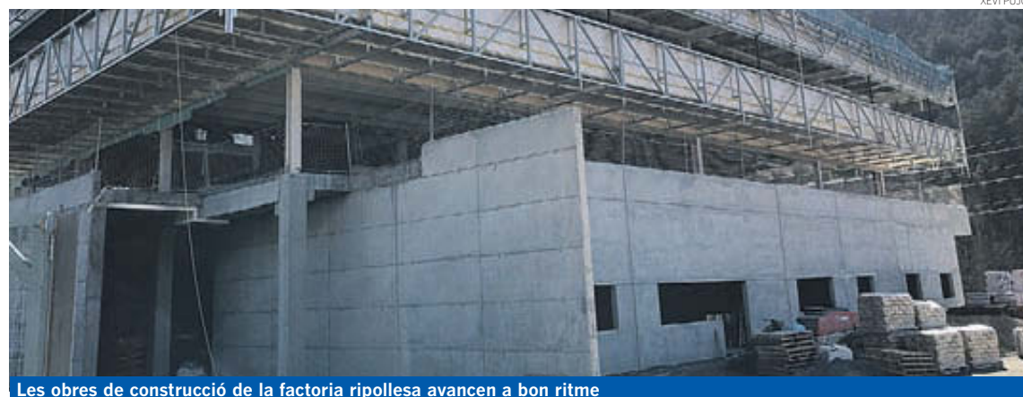
Les obres de construcció de la factoria ripollesa avancen a bon ritme
