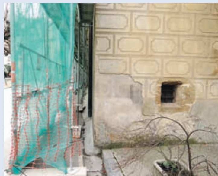
Els operaris ja han iniciat les obres de restauració
