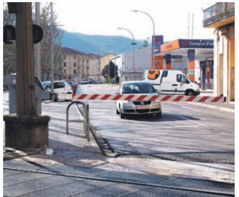
L'avaria de les barreres van provocar problemes circulatoris
