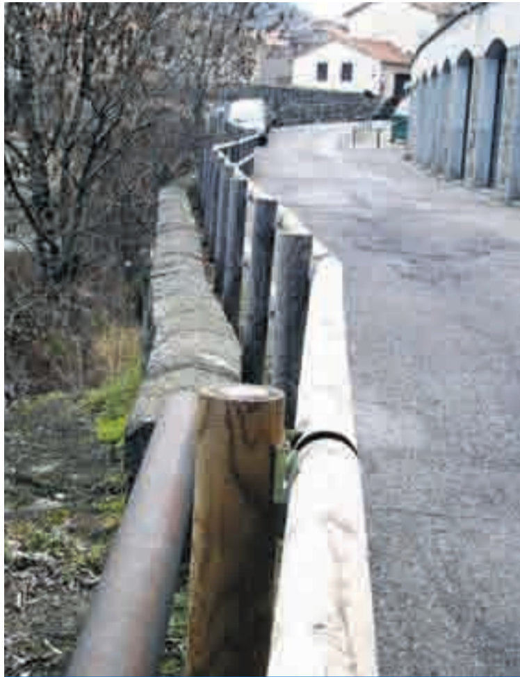
Les tres baranes, de fusta, ferro i obra, al raval de Barcelona de Ripoll
