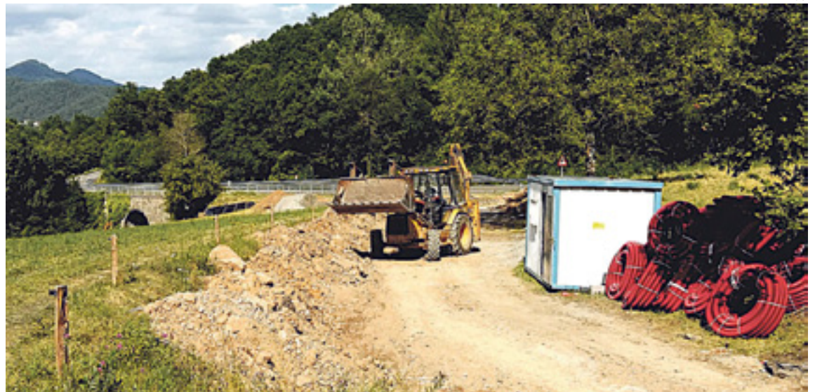
Una de les màquines treballant en les obres d'urbanització del polígon
