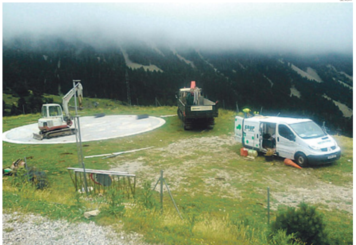
Aquests dies han començat les obres d'adequació d'aquesta instal·lació
